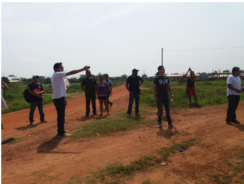
FOTO 1 - recorrido instalaciones para construcción de 30 viviendas de apoyo institucional
