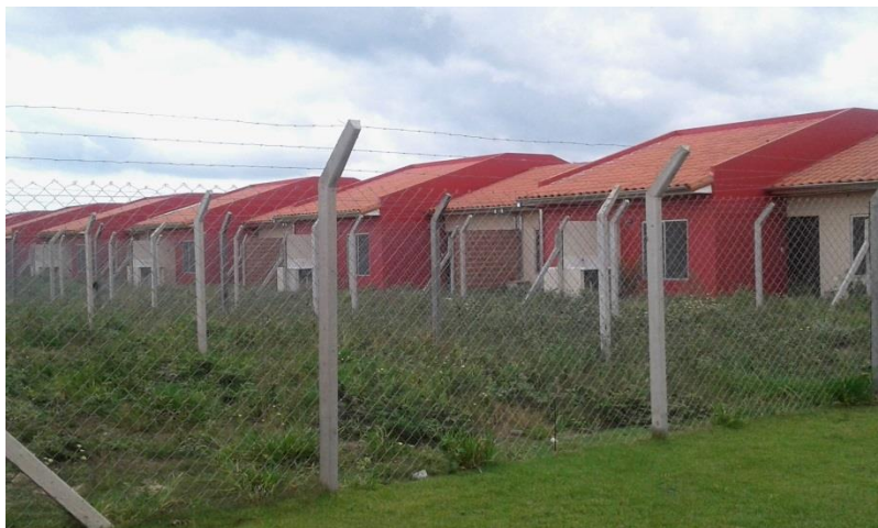
FOTO 6 - INSPECCIÓN 40 VIVIENDAS HABITAD BOLIVIA
